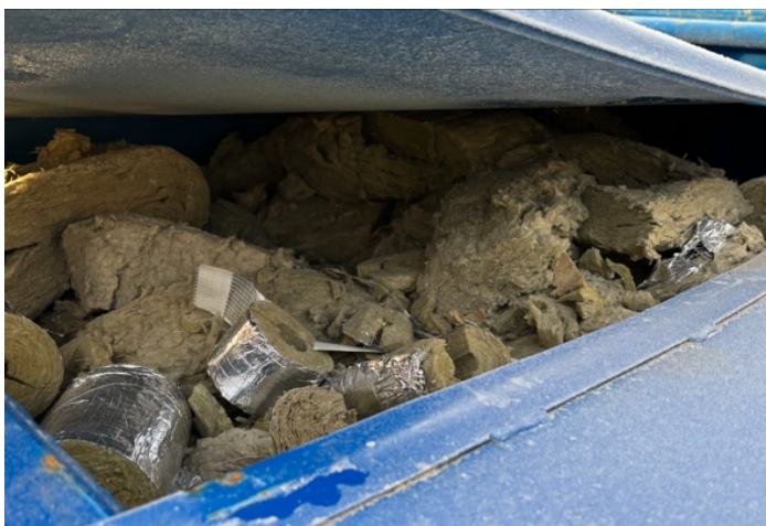
Kuva: Mittaviiva / Uudenmaan Mestari-Rakentajat Oy
