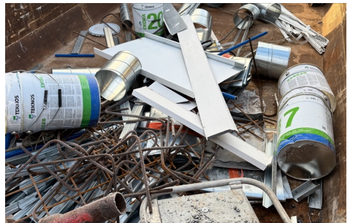
Kuva: Mittaviiva / Uudenmaan Mestari-Rakentajat Oy
