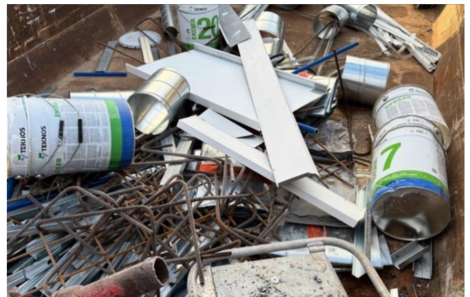
Kuva: Mittaviiva / Uudenmaan Mestari-Rakentajat Oy
