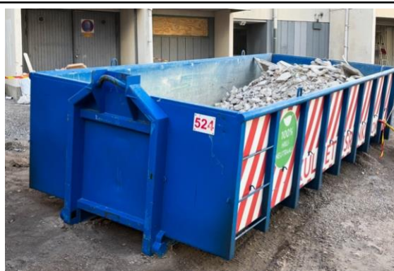
Kuva: Mittaviiva / Uudenmaan Mestari-Rakentajat Oy
