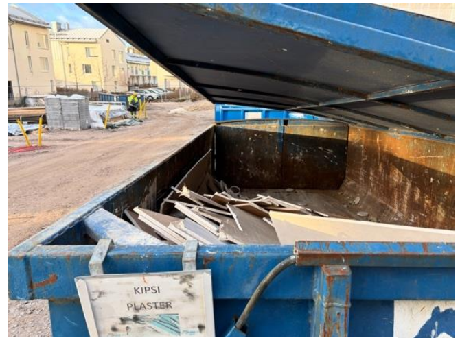
Kuva: Mittaviiva / Uudenmaan Mestari-Rakentajat Oy
